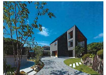
新社屋（R5.1月完成）
