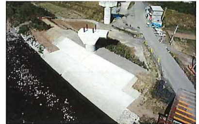
施工事例（水俣IC付近橋脚工事）
