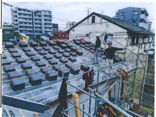
屋根・作業風景
