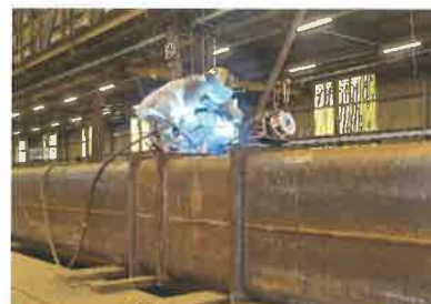
柱を溶接しています
