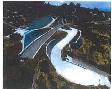
施工工事写真
