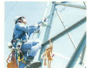
送電線作業写真
