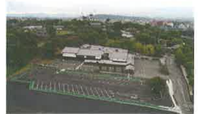
合同庁舎跡地駐車場整備工事
