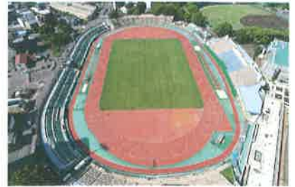
水前寺競技場トラックその他改修工事
