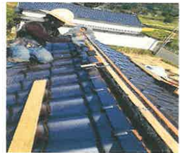
防災和形瓦施工
