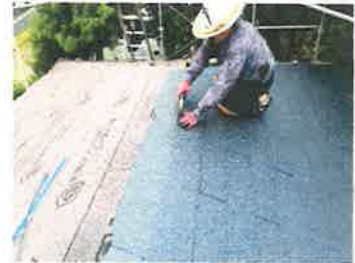
軽量屋根瓦施工
