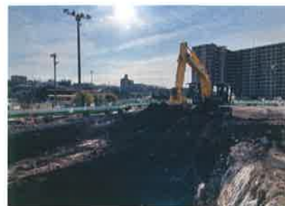
工事現場の様子
