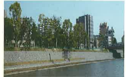
白川大江護岸工事
