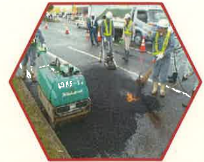
熊本地震復興工事：田井ノ島交差点
