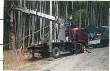
岩盤掘削車を使用しての作業
