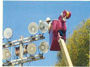
高所作業車を使用しての作業
