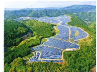
土木工事の施工事例
