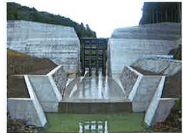
工事現場完成写真
