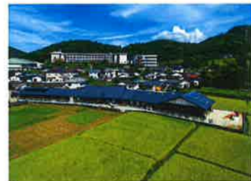
工事現場完成写真
