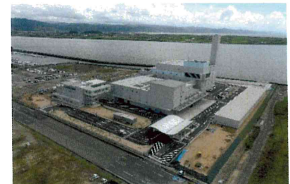
工事現場の様子（外構施工）
