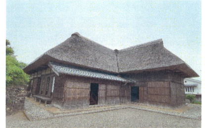
修復作業をした重要文化財太田家住宅
