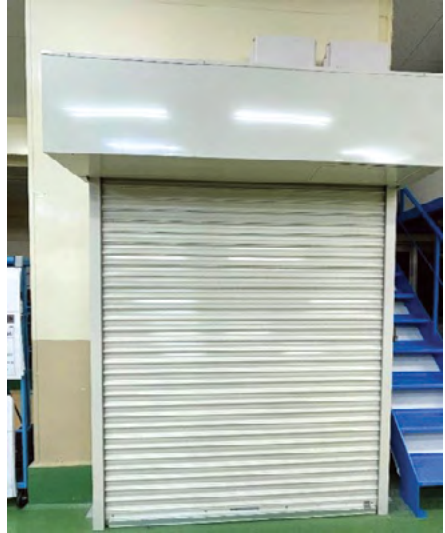
荷物用昇降機の開閉口の前に密閉式の電動シャッターを設置（改善後）
