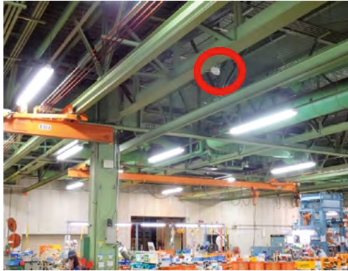
天井に新たに設置したライト
