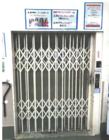
荷物用昇降機（改善前）
