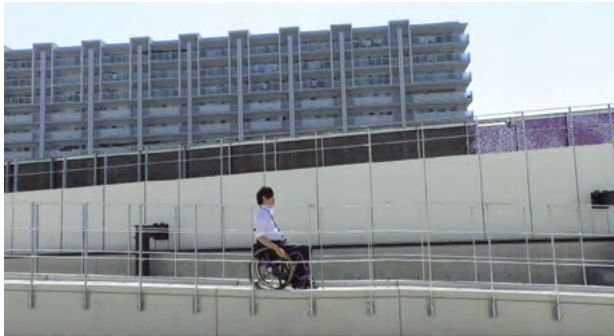
外周を取り巻く傾斜の緩やかなスロープ
