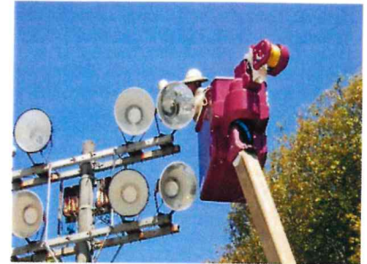
高所作業車を使用している作業
