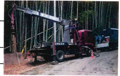
岩盤掘削車を使用している作業
