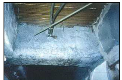
石綿による鉄骨の耐火被覆 ※12
