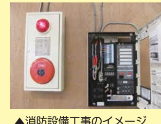
▲消防設備工事のイメージ
