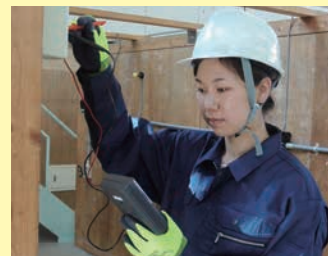
▲電気配線の検査
