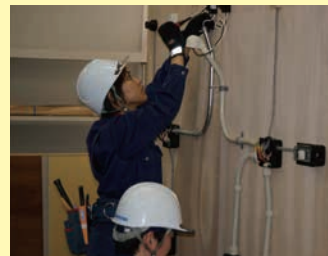
▲電気配線の施工実習
