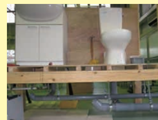
▲配管から衛生器具の取付
