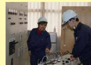
▲受変電設備の試験
