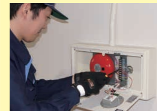
▲消防設備の配線実習
