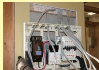
▲住宅配線 (分電盤の取付)
