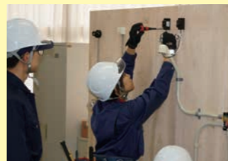
▲配管・配線の実習 (電気機器取付)
