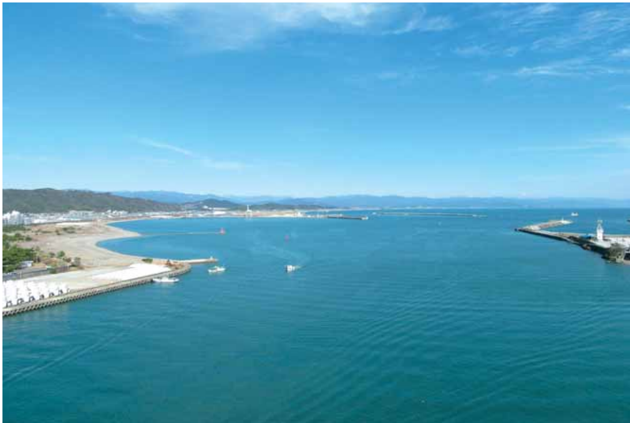
浦戸湾・高知新港（浦戸大橋から）
