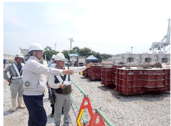
局長安全パトロールの様子
