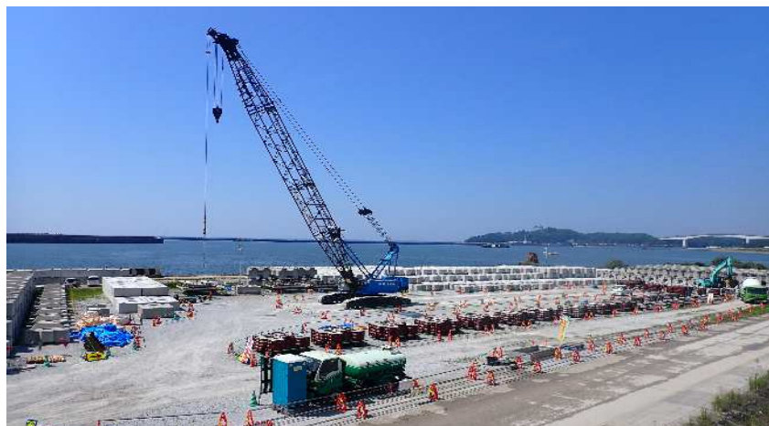
パトロール対象工事現場の全景
