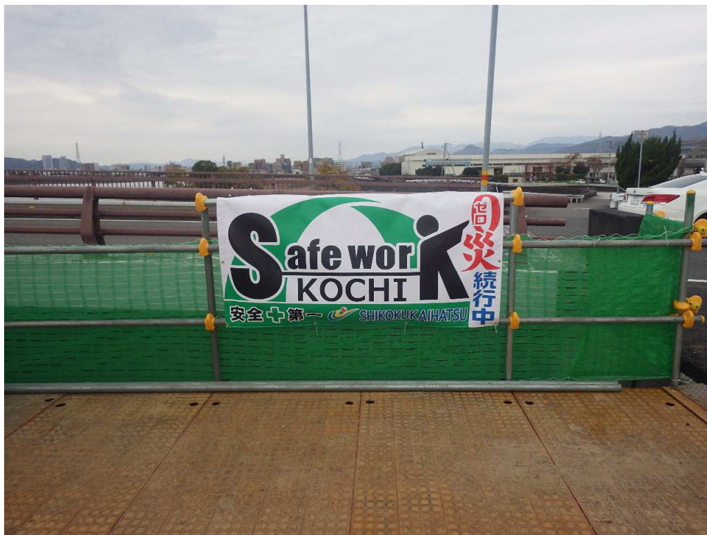
平成28-29年度 国分川橋下部第2工事
