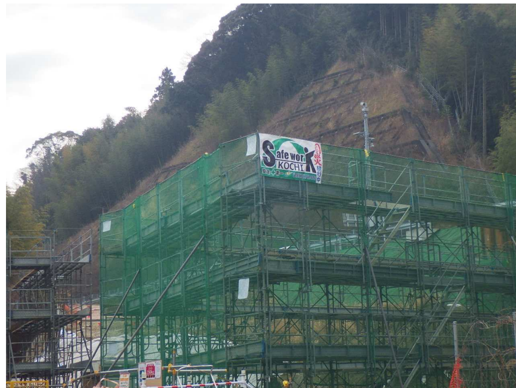
平成28年度 東孕改良工事
