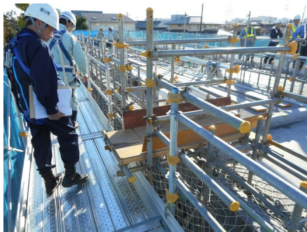
墜落防止のための手すり よし！ 落下防止のための幅木、防網 よし！ 強風、大雨等の悪天候時の点検 よし！
