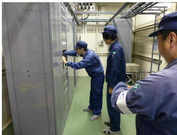
* 現場安全パトロール
