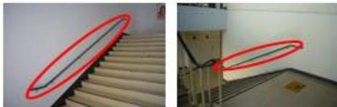
南北両地区の厚生棟の階段（片側手すり）に、手すりを増設し両側手すりに改良
