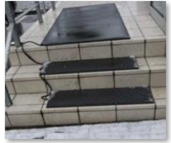
<ヒートマットの設置例>
