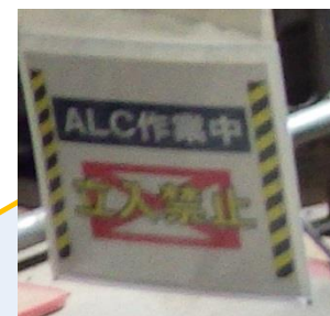
写真25 (左)、26 (上) 【高所作業車の作業場所】 高所作業車作業場所の 立入禁 止区域 を赤色のセーフティーコ ーンとコーンパーで分けけし、パ ーに「 立入禁止 」表示をしている。 また、 作業内容がALC板の作業 であることもパーに表示している。 (立ち入り禁止区域の見える化、 立入禁止区域内での作業内容の 見える化)
