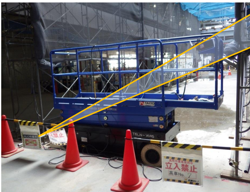
写真25 (左)、26 (上) 【高所作業車の作業場所】 高所作業車作業場所の 立入禁 止区域 を赤色のセーフティーコ ーンとコーンパーで分けけし、パ ーに「 立入禁止 」表示をしている。 また、 作業内容がALC板の作業 であることもパーに表示している。 (立ち入り禁止区域の見える化、 立入禁止区域内での作業内容の 見える化)
