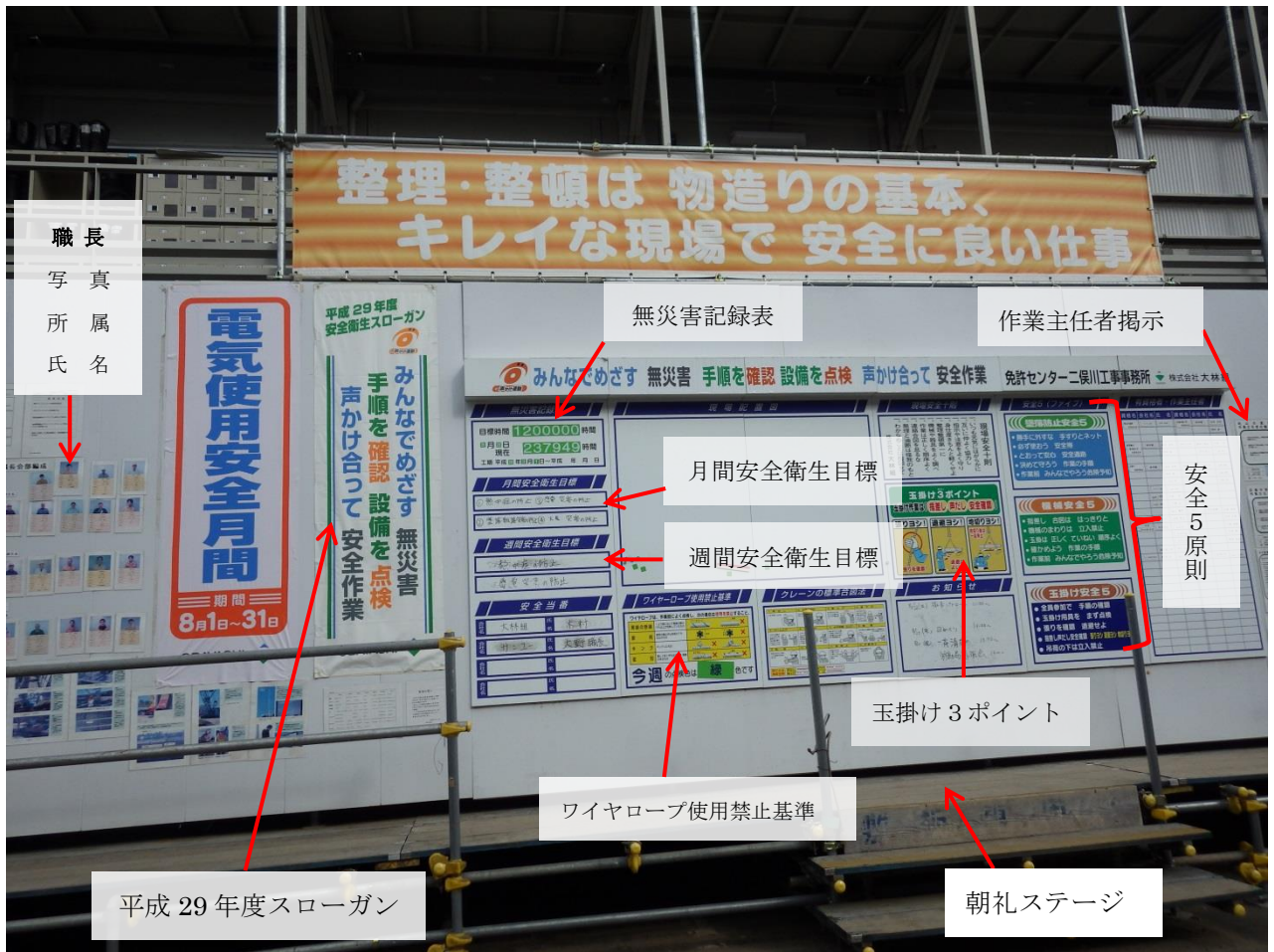
写真7 【工事事務所前の全体朝礼場所の安全ボード（安全掲示板）】 年度スローガン、無災害記録表、月間安全衛生目標、週間安全衛生目標、職長掲示、作業主任者掲示、安全5原則（墜落防止安全5、機械安全5、玉掛け安全5 各重要5項目）等（スローガン、目標、安全の原則、作業主任者、職長等の見える化）
