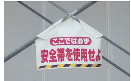
写真22 (左)、23 (上) 【足場上の安全帯使用場所1】 枠組足場上での安全帯使用 を表示し、 安全帯の使用を徹底 している。 (安全帯使用場所の見える化)
