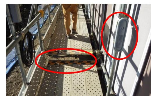
通路段差手前を通過時に音声で段差を知らせ、また、段差箇所にはトラ縞のテープを貼り、分かりやすくしている。
