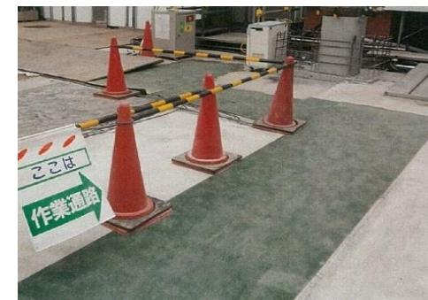
通路はカラーコーン、コーンバーで区分するだけでなく、通路床部分に緑色のマットを設置し、作業通路であることを明示している。マットは滑り止めの役割もある。
