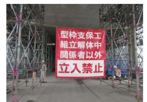
関係者以外の立入禁止を大型表示し、立入禁止理由が型枠支保工の解体作業中であることも明示している。
