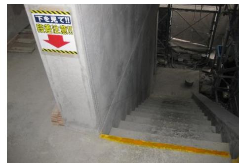
床面と階段の段差について壁側面に注意喚起の表示をし、また、最上段端部に蛍光色のラインを引き、分かりやすくしている。
