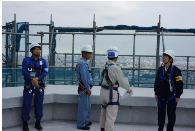
高所作業における墜落転落防止措置について 確認する川崎南・川崎北労働基準監督署長、 川崎市経済労働局長
