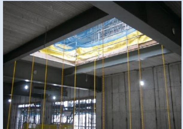
水平ネットで開口部を養生している。 開口部端から垂らした黄色の鎖で 開口部の真下の範囲を示し注意喚起している ○飛来落下災害防止の注意喚起
