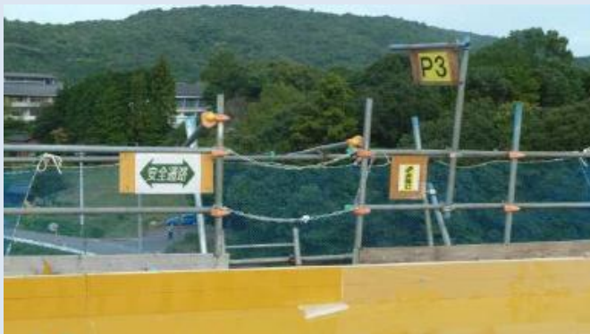
黄色のネットと安全通路の表示で、安全通路を確保、 明示している。単管は墜落転落防止の役割を果たしている ○安全通路の明示による注意喚起
