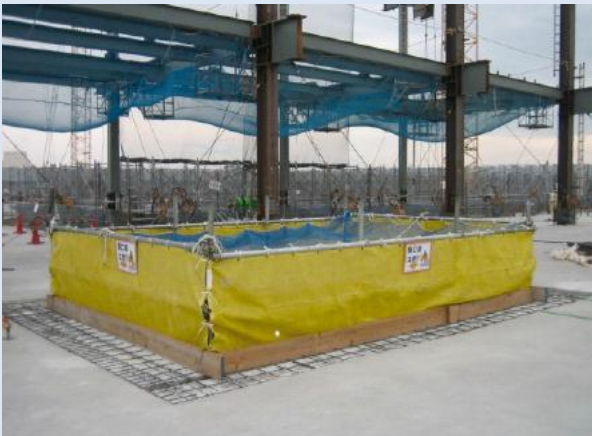
範囲内が開口部であることを 黄色のネットで注意喚起 ○色による注意喚起
