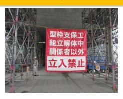
関係者以外の立入禁止を大型表示し、立入禁止理由が型枠支保工の解体作業中であることも明示される。
