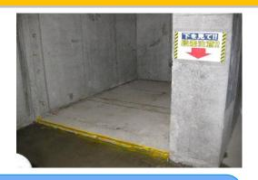
床 面 の段 差 について壁 側 面 に表 示をし、段 差 箇 所 (上 面 と側面)に黄 色 の蛍 光 色 のラインを引き、分 かりやすくしている。
