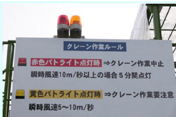
パトライトとクレーン作業の規則の掲示
