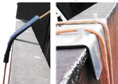
切断防止措置の例 (置き型養生) ▲
