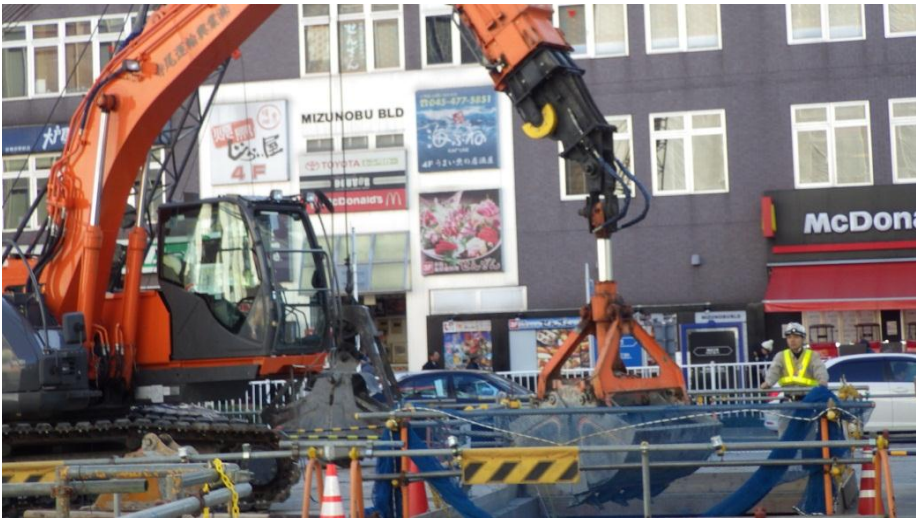
写真17 【現場パトロール14】 掘削土を地上に搬出する テレスコクラム
