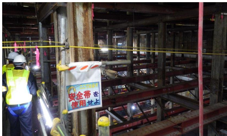
写真14 (左写真) 【現場パトロール11】 通路段差箇所に「足もとと注意」の表示をするとともに、音声で注意喚起 (聞こえる化) 写真15 (右上写真) 【現場パトロール12】(右上写真) 階段通路の頭上低い箇所に「頭上注意」の表示をしている。 写真16 【現場パトロール13】(右下写真) 安全帯使用箇所に、「安全帯を使用せよ」の表示をしている。
