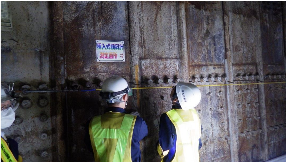
写真13 【現場パトロール10】 鋼製連壁による土留めについて、傾斜計により測定を行っていることを測定箇所を確認しているところ
