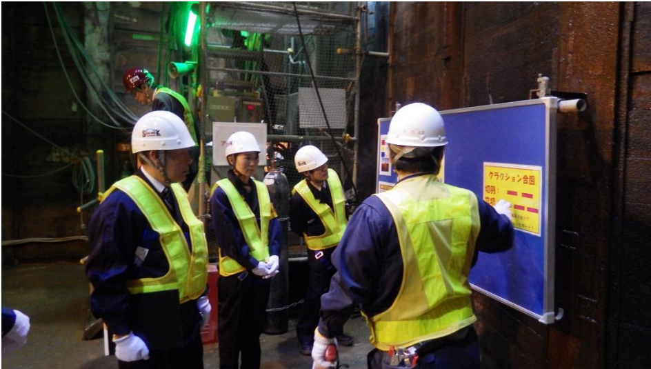
写真5 【現場パトロール2】 立坑内最下部において、坑内での合図等ルールについて説明を受けているところ （坑口から深さ21mの位置）
