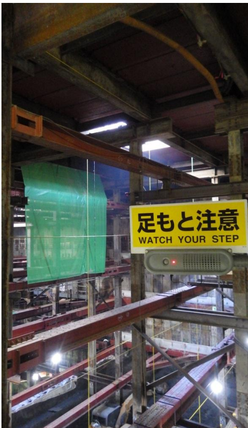
写真14 (左写真) 【現場パトロール11】 通路段差箇所に「足もとと注意」の表示をするとともに、音声で注意喚起 (聞こえる化) 写真15 (右上写真) 【現場パトロール12】(右上写真) 階段通路の頭上低い箇所に「頭上注意」の表示をしている。 写真16 【現場パトロール13】(右下写真) 安全帯使用箇所に、「安全帯を使用せよ」の表示をしている。
