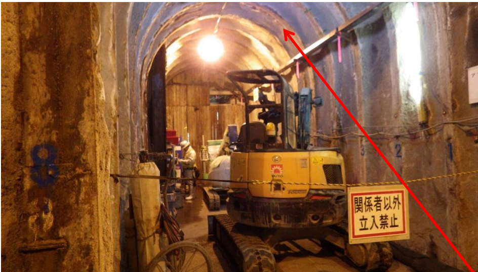
写真6 【現場パトロール3】 市営地下鉄新横浜駅 躯体下部を仮受するための導坑の状況を確認（NATMによる掘削途中の段階、仮受杭設置前）
