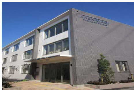
校舎全景です。(南東より)
