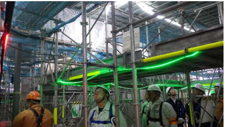
LEDチューブライトを作業通路に配し、色分けして立入禁止や指定業者の通行可といったルールを新規入場者や外国人作業者にも容易に理解できる取組
