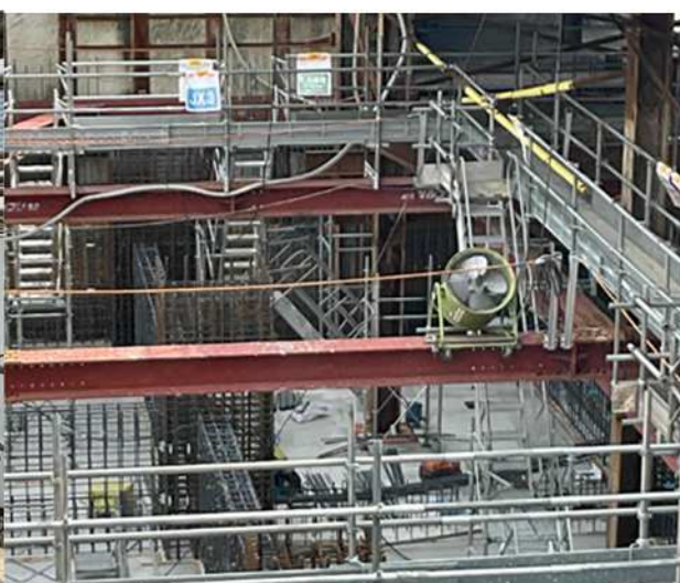
↑ 大型送風機で作業構台の下の風の流れに工夫
