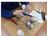
屋内電気配線
