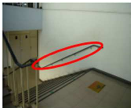
南北の両地区の厚生棟の階段（片側手すり）に、手すりを増設し両側手すりに改良
