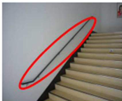
南北の両地区の厚生棟の階段（片側手すり）に、手すりを増設し両側手すりに改良
