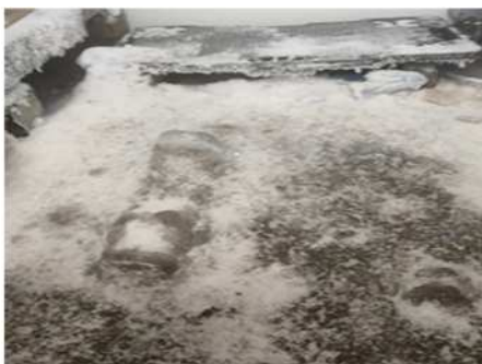
冷凍庫床氷除去前
