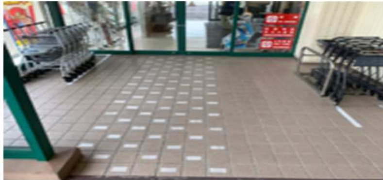
白い箇所が滑り止めを貼った箇所
