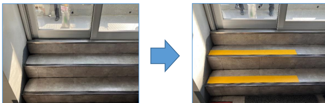
<滑り止めテープ貼り付け前>
