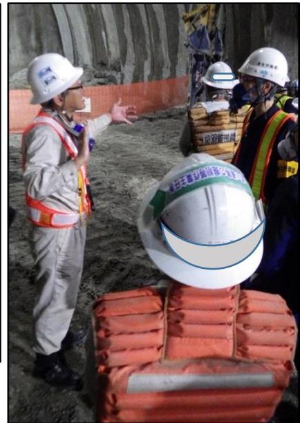
写真右：バックプロテクター（写真手前及び奥のベスト調の保護具）の装着状況
