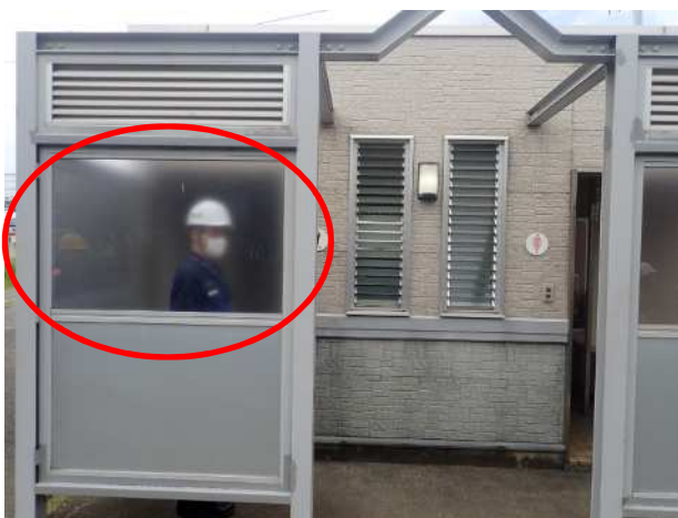
( 中が見えないようにトイレの出入口に設けられた壁について、出会いがしらの衝突防止のため上半分がすりガラスになっている(以前は下半分と同様の素材であり、ヒヤリハットがあったとのこと。)。 )
