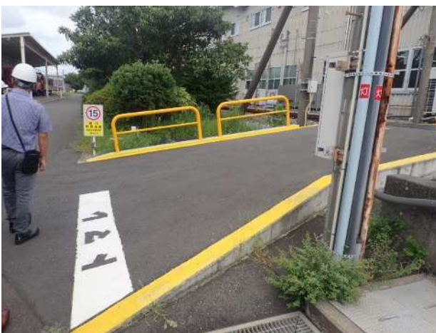
( 黄色の塗装により通路及び手すりを明示することにより「見える化」を図り、安全通路を確保している。なお、黄色の塗装は半年ごとに塗り直している。 )
