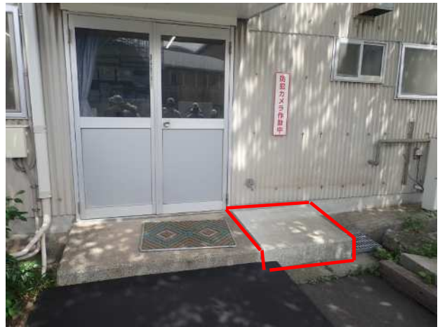
( 赤線で囲った部分を増設し、ドアの出入り時に足を踏み外して転倒する災害の未然防止を図っているもの。 )
