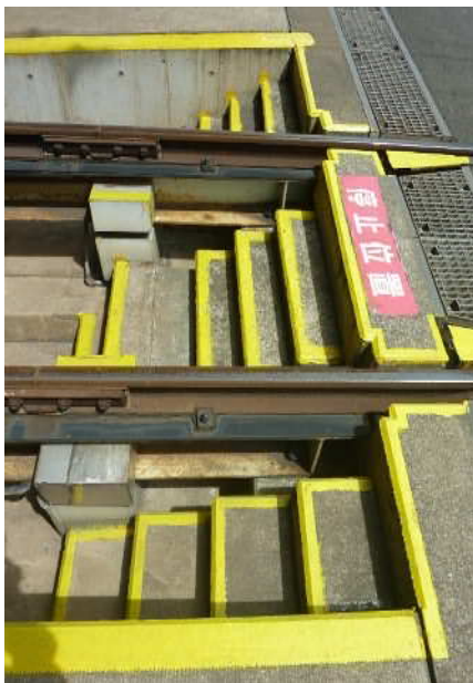
( 昇降設備や墜落、転落、転倒等の危険箇所はすべて黄色で塗装されている。 )
