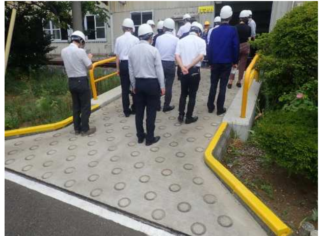
( スロープについて、滑り止め加工が施され、また、端部は黄色に塗装されている。 )
