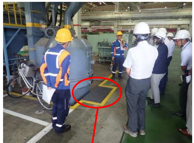
( スロープについて、滑り止め加工が施され、また、端部は黄色に塗装されている。 )
