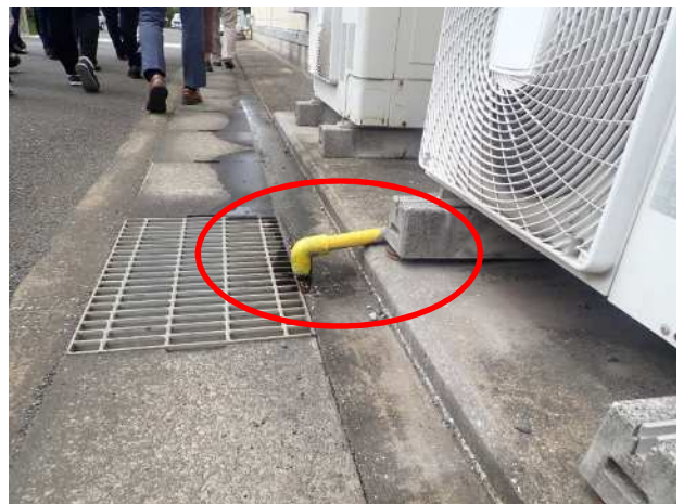
（少しの段差であっても黄色の塗料で塗装し、注意を促している。）
