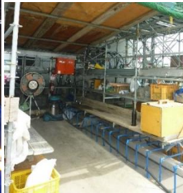
橋面上に設けた日除けのエリア
