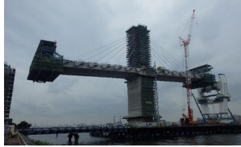
施工現場全景 天秤状の中央の塔が M P 2 とピロン柱、右端の白いブロックが M P 3 の主塔です。
