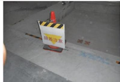
床面の段差手前箇所に注意喚起の表示をしたカラーコーンを設置し、段差周囲の床面に(部分的に)トラクションのテープを貼り付け、分かりやすくしている。
