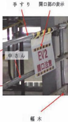
壁面の開口部がエレベーター2号機の設置箇所であることを表示している。単管の手すり、中さんの設置による開口部からの墜落防止措置、幅木の設置による物体の落下防止措置を講じている。
