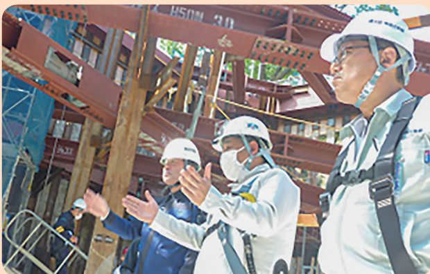
労働局による現場パトロール
