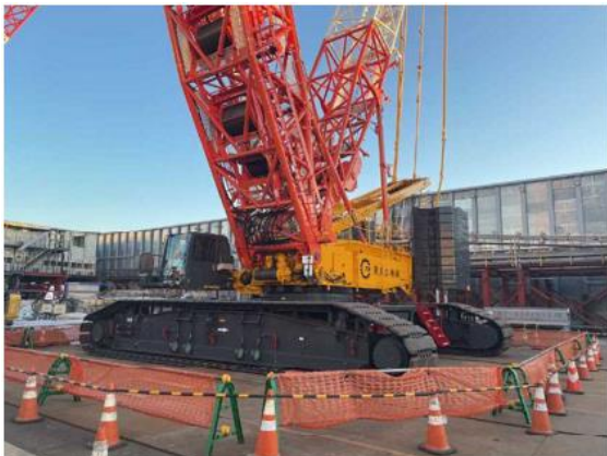
作業範囲に2重の立入禁止措置
