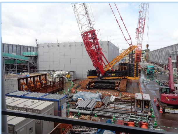
パトロール現場の全景
