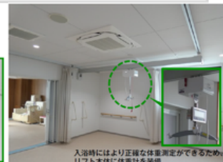
入浴時にはより正確な体重測定ができるため、リフト本体に体重計を装備。
